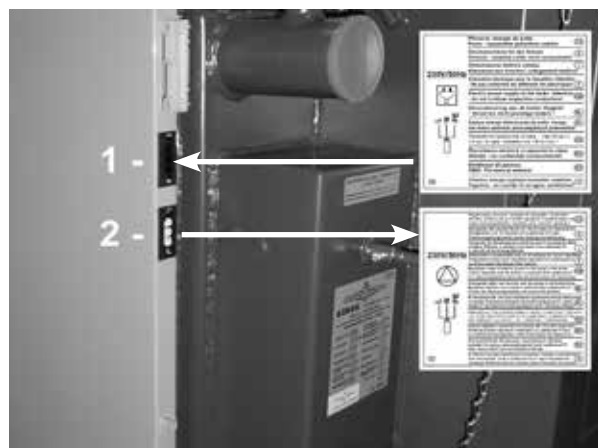
Steckverbindungen in der rechten Kesselabdeckung
