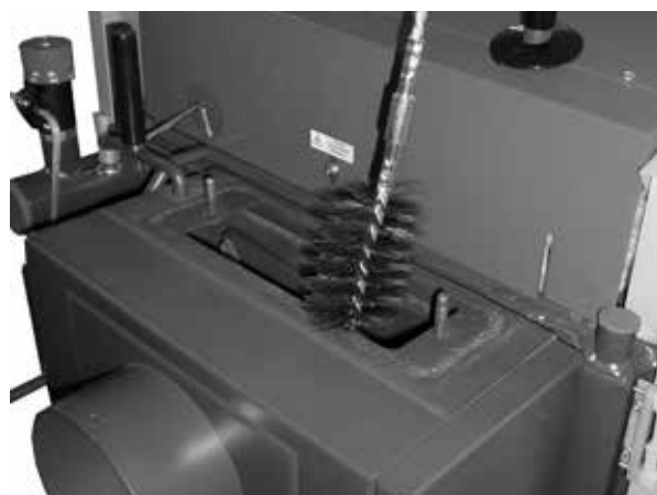
Vorführung der Reinigung des Rauchkanals mit Drahtbürste.
