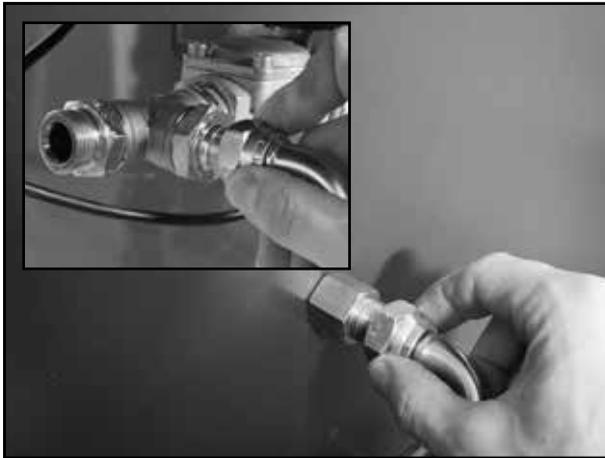
Anschluss des Verbindungsschlauches (1/2“) an den Kessel und an die Abzweigung (T-Stück) am Brenner
