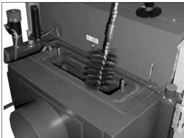
Vorführung der Reinigung des Rauchkanals mit Drahtbürste.
