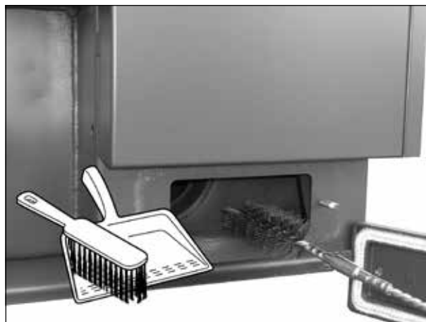
Vorführung der Reinigung des Rauchkanals mit Drahtbürste.
