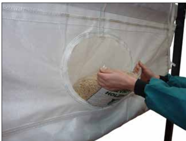
Ukázka náhradního plnění textilního zásobníku peletami z pytlů přes plnicí rukáv
