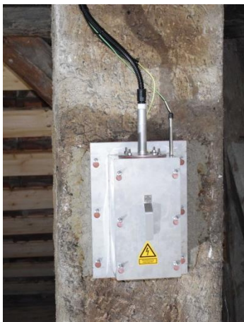
7. Serviceöffnung schliessen und elektrische Verbindung zur Steuerung herstellen.
