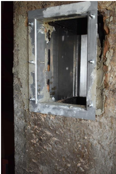
5. Rahmen mit Mörtel im Mauerwerk einputzen und ausrichten.
