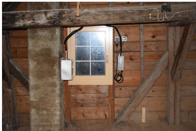
8. Kabel mit Reserveschleife verlegen. Demontage für Reinigungsarbeiten nötig.
